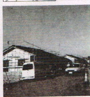
大熊町役場の近く、備される災害公営
